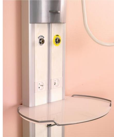
Montage robuste et modulaire des prises fluides de toutes marques, fixation sur étriers inox et finition par couvercle en fonte d'aluminium laqué blanc ou gris.
