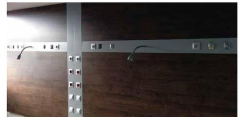
L'encastrement de la gaine technique est conçu pour être sur le même plan que le panneau pour des raisons d'hygiène et esthétique.
