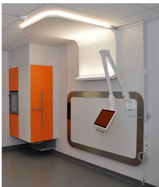
3 platines LED 16 w / 1 890 lm + ruban 44 w / 5 500 lm soit total de 92 w (110 w avec convertisseurs) / 11 170 lm
