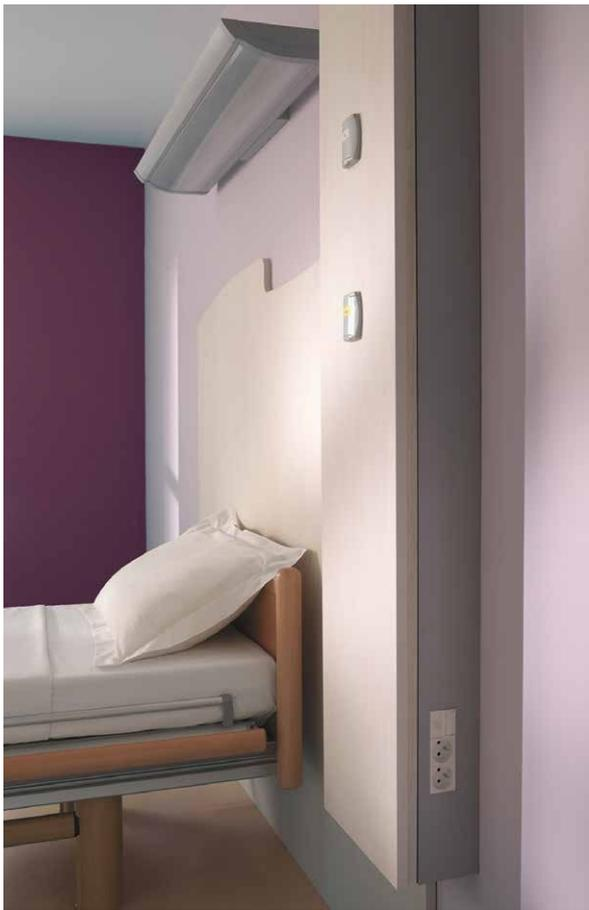
La colonne BLUE BEETLE adopte le principe de la distribution verticale des fluides nécessaire aux postes de soins.
